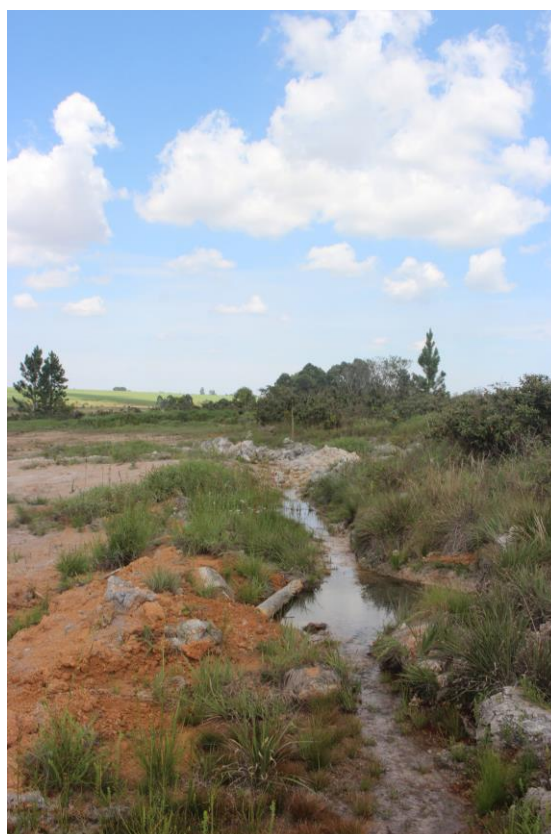
Foto 20: Intervenção em APP com a instalação de drenos na área 02.
