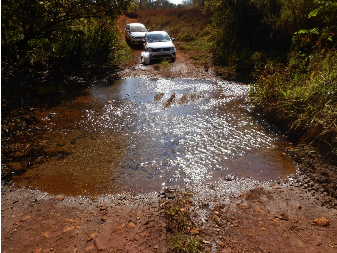
Foto 88: Estrada não pavimentada cruzando o Córrego do Buracão UB40.
